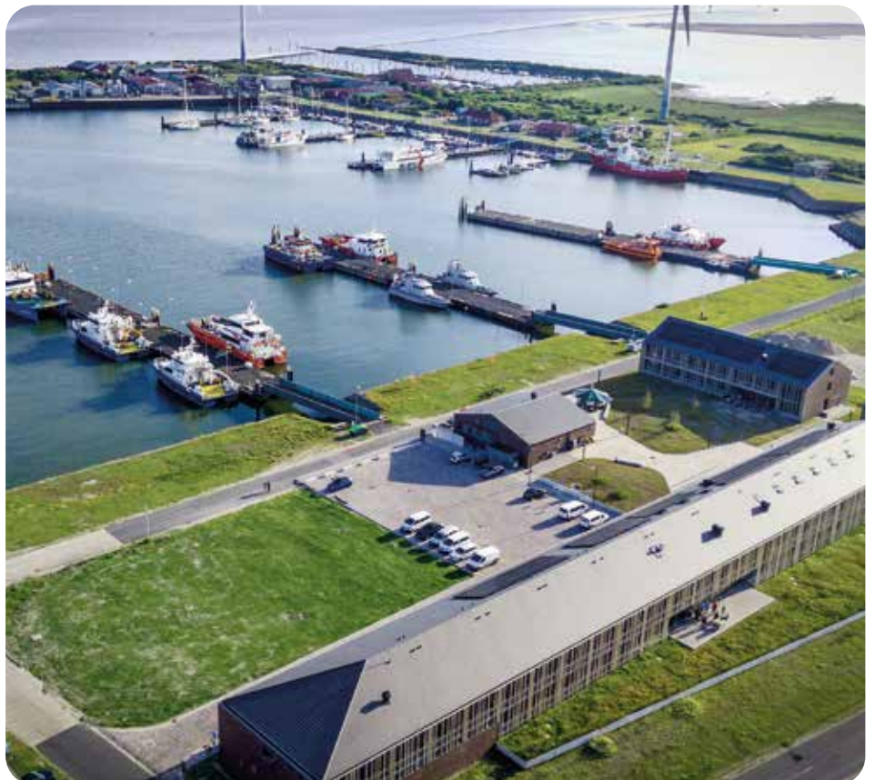
Auf dem ehemaligen Gelände der Marine ist ein idealer Servicestandort für die Offshore-Windparks in der Deutschen Bucht entstanden.
