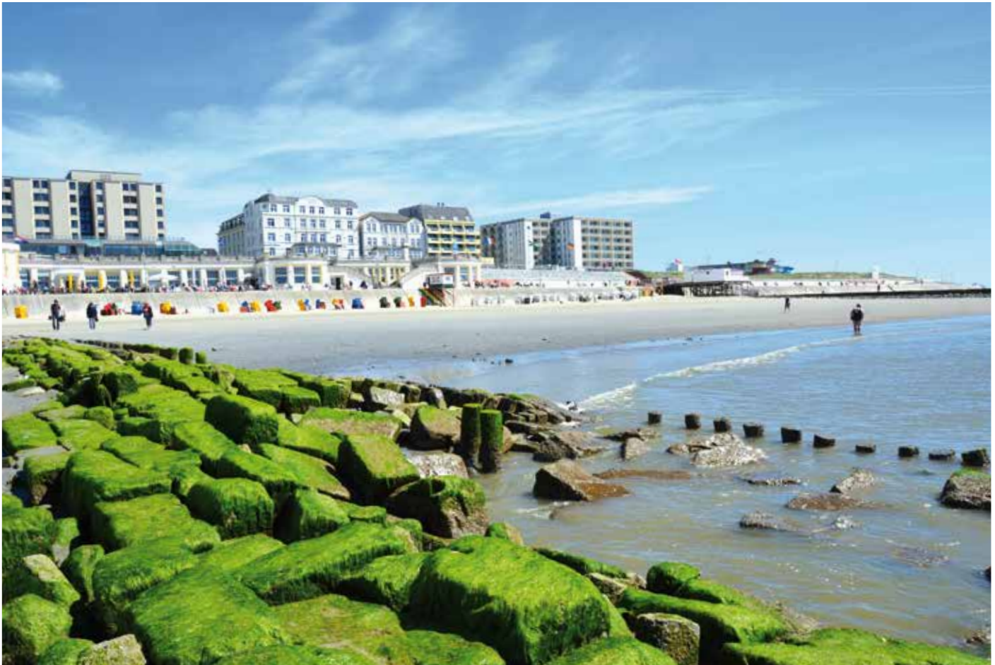
Als Baumaterialien für die Buhnen verwendete man massive Basaltblöcke sowie das harte und schwere Holz der Lärche
