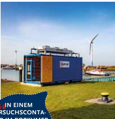
IN EINEM VERSUCHSCONTAINER IM BORKUMER SCHUTZHAFEN WIRD AUS NORDSEEWASSER WÄRME ERZEUGT.
