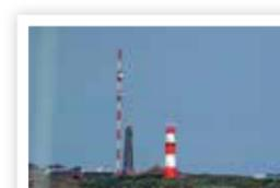
► **Richtfunkmast**, neben dem Kleinen Leuchtturm, Baujahr 1967, Die Höhe betrug damals 55 m. Der Mast ist kein Radarturm, sondern überträgt Richtfunk und UKW. 1988 wurde er um zwölf Meter auf 67 erhöht, 2011 der Mast abgebaut und durch einen neuen 100 m hohen Gittermast ersetzt.
